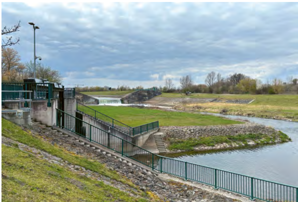
Abb. 17: Typisches Wasserbauwerk zur Regulierung der Weißen Elster im Gewässerknoten Leipzig
